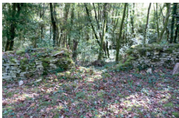
Mur de soutènement avant la restauration
