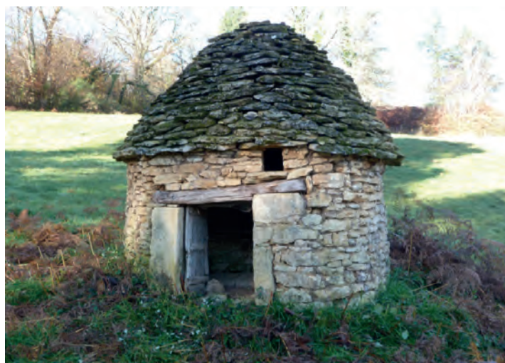
Cabane aux Taillades après la restauration
