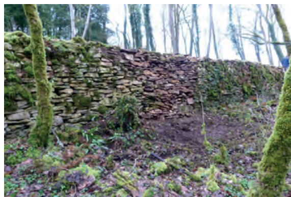
Mur de soutènement après la restauration
