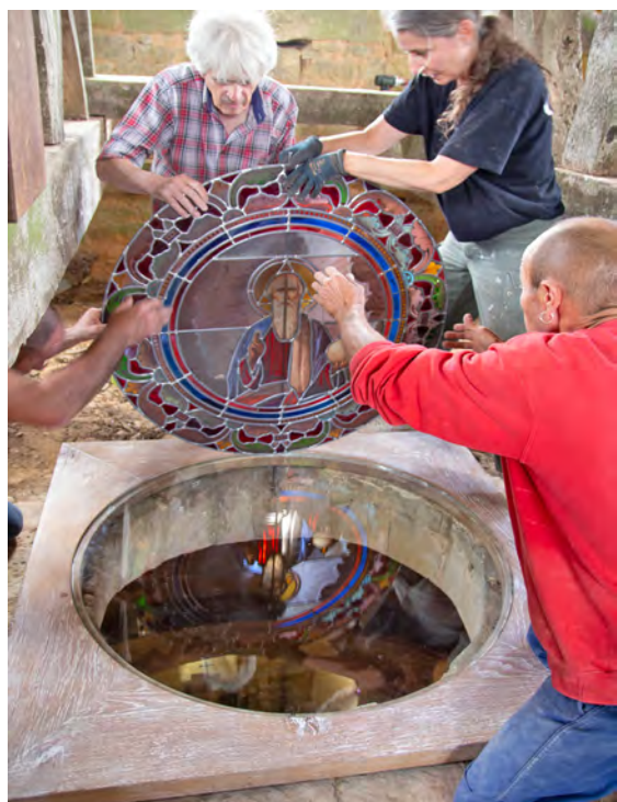
Installation du vitrail restauré situé au dessus de l'oculus
