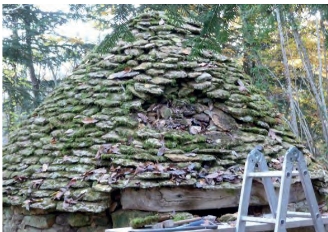
Le lierre qui a couvert la cabane au champ de la Croix d'Alix et qui a fait beaucoup de dégâts est enlevé. Une partie du mur et du toit en lauzes est tombée et nous avons commencé à restaurer cette cabane.
