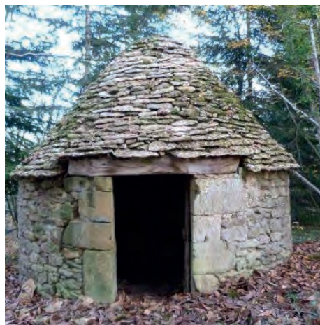
Le lierre qui a couvert la cabane au champ de la Croix d'Alix et qui a fait beaucoup de dégâts est enlevé. Une partie du mur et du toit en lauzes est tombée et nous avons commencé à restaurer cette cabane.
